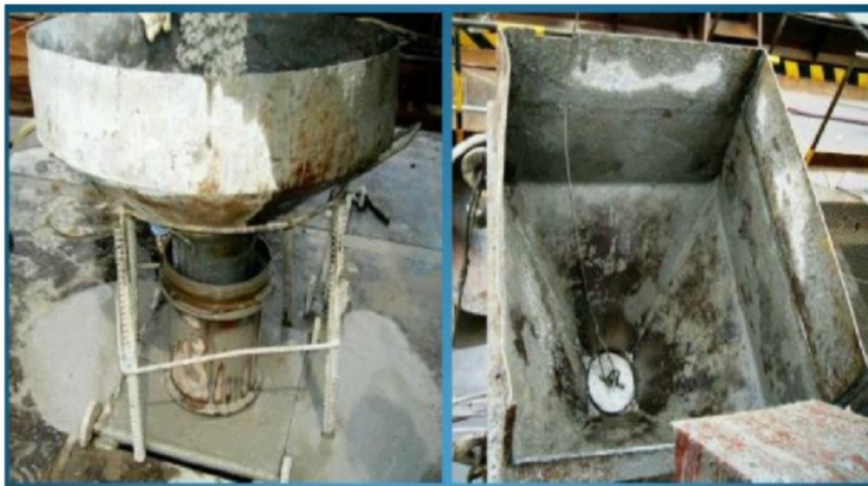
料斗安装牢固
